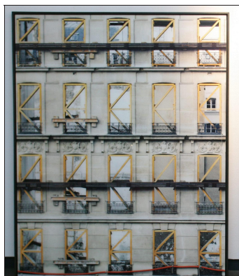
Une façade d'un immeuble...
